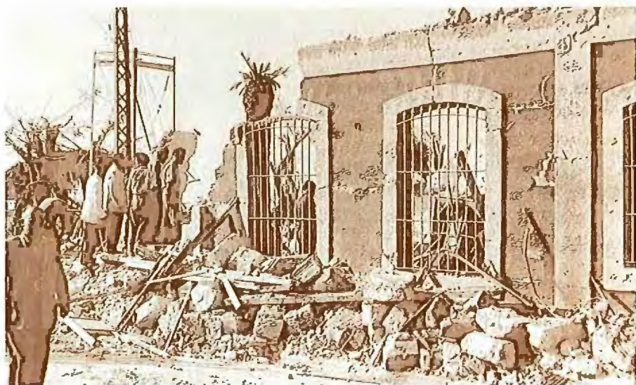
Aspecto que ofrecía una de las numerosas casas destruidas en la barriada de San Severiano. Abajo, estado en el que quedó el edificio de la Casa Cuna gaditana.
