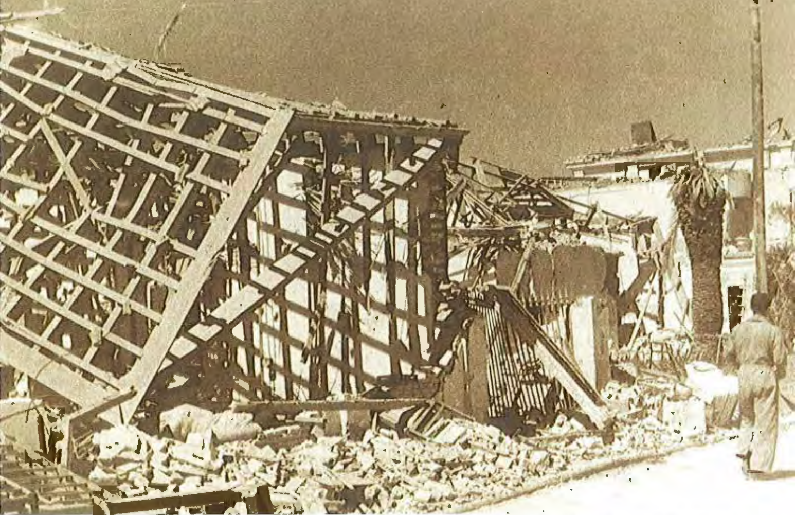
Tras la explosión numerosas zonas de la ciudad quedaron reducidas a montones de escombros. En la fotografía inferior, imagen de las minas que no llegaron a estallar, almacenadas en un edificio contiguo al siniestrado.
