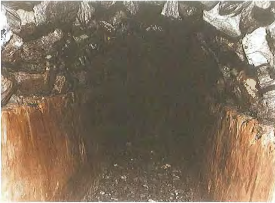
Detalle del canal subterráneo de captación de aguas del acueducto. Carmen Sánchez Ruiz-Jiménez.
