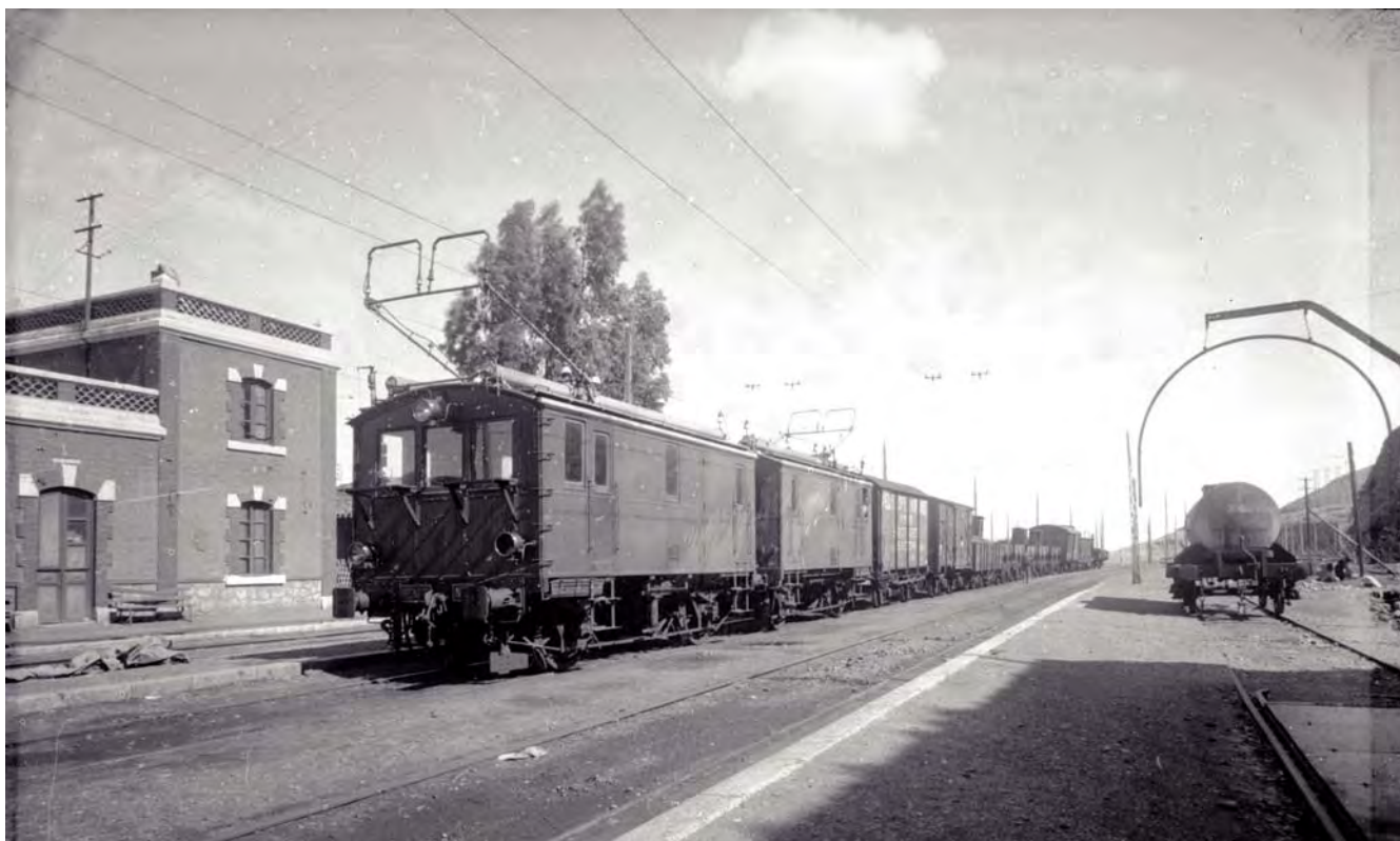
Motores trifásicos en la estación de Gádor en la década de 1930 (fotografía: Museo del Ferrocarril de Delicias).
