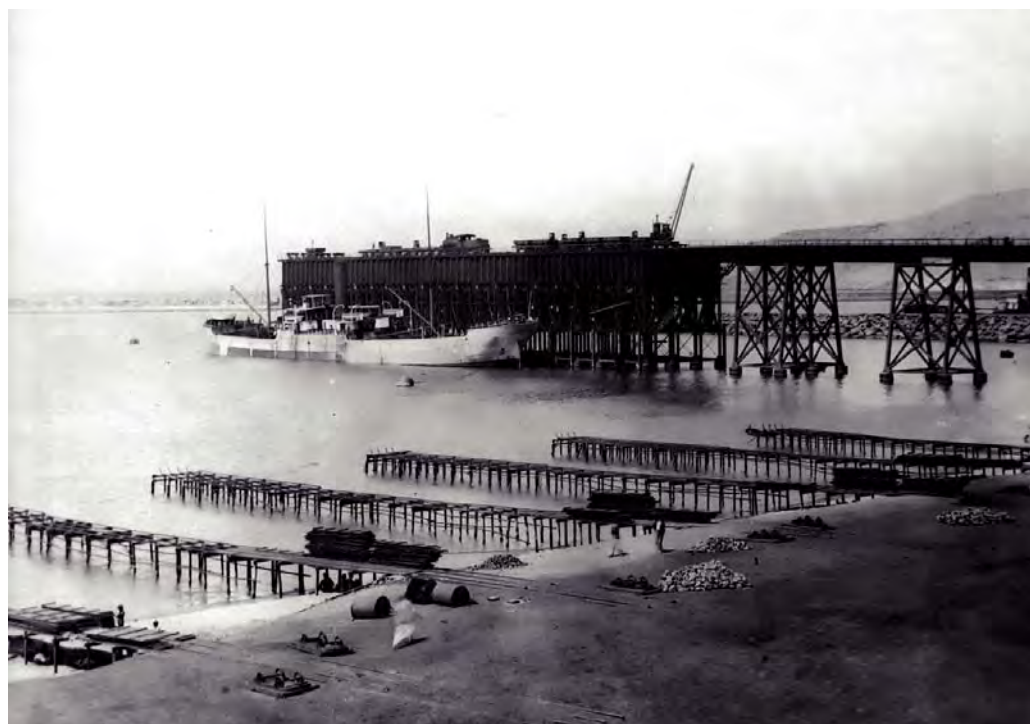
Arriba, el Embarcadero de Alquife (el Cable Inglés), en el puerto de Almería, construido en 1904 para agilizar las operaciones de carga y descarga de mineral de hierro (Fondo Asafal). Abajo, la estación de ferrocarril de Almería. En la página anterior, acción de la Compañía de los Caminos de Hierro del Sur de España (1891).
