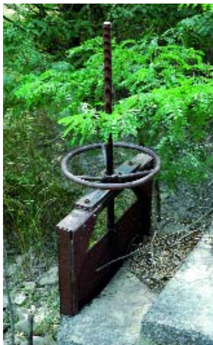
Compuerta de hierro en la Laguna Grande.
