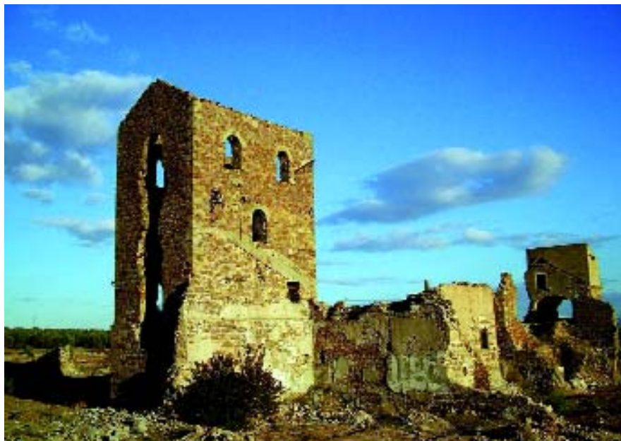
Casa de máquinas de bombeo en el Pozo San José de las Minas de Arrayanes.
