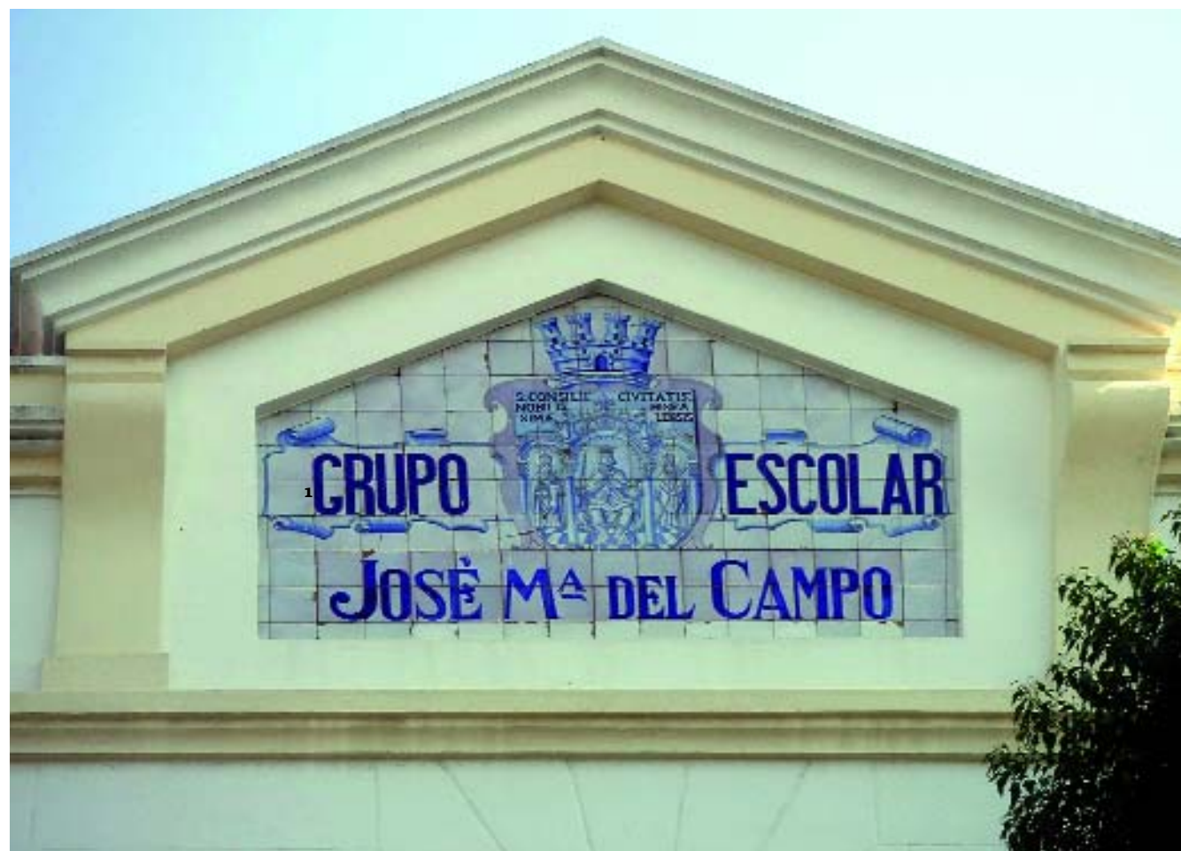
Azulejos de la fachada del colegio José M a del Campo, en la calle Pagés del Corro de Sevilla, en los que se observa la corona mural.
