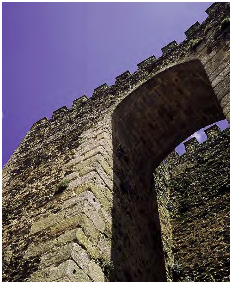
Un matacán corrido une las dos torres que protegen el castillo de Cumbres Mayores.
