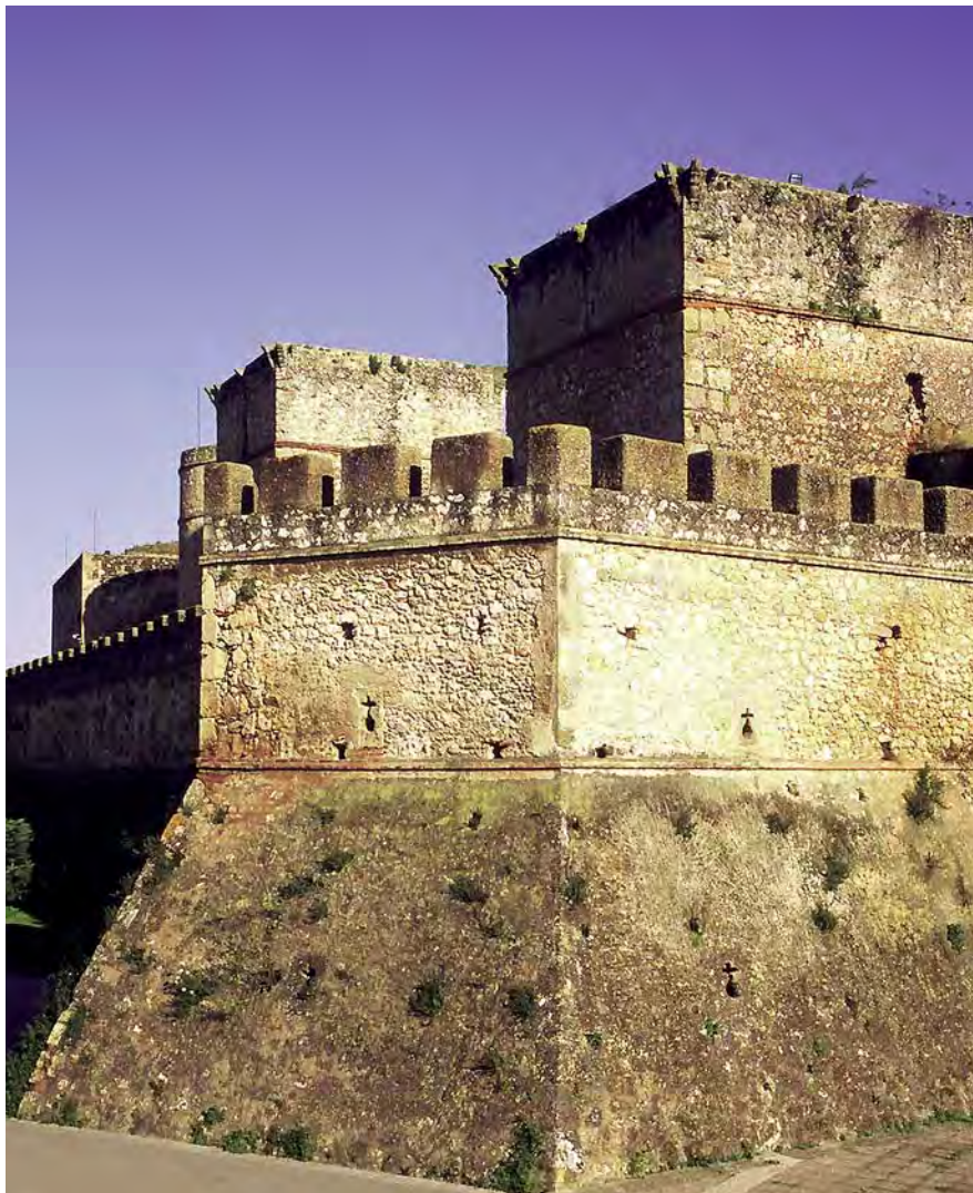
La fortaleza de Niebla se protegió con un antemuro al final del siglo XV.
