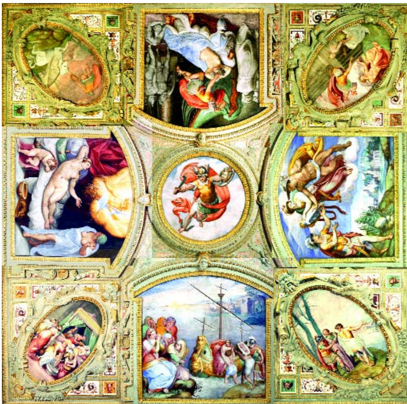
Vista general del techo de la Torre de la Reina del palacio de El Pardo, Madrid.
