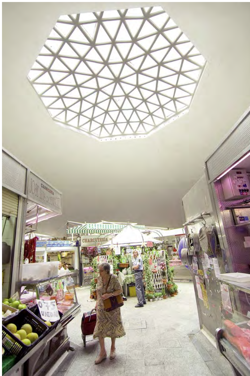
Mercado de Abastos de Algeciras (1933-36), de E. Torroja Miret y M. Sánchez Arcas.
