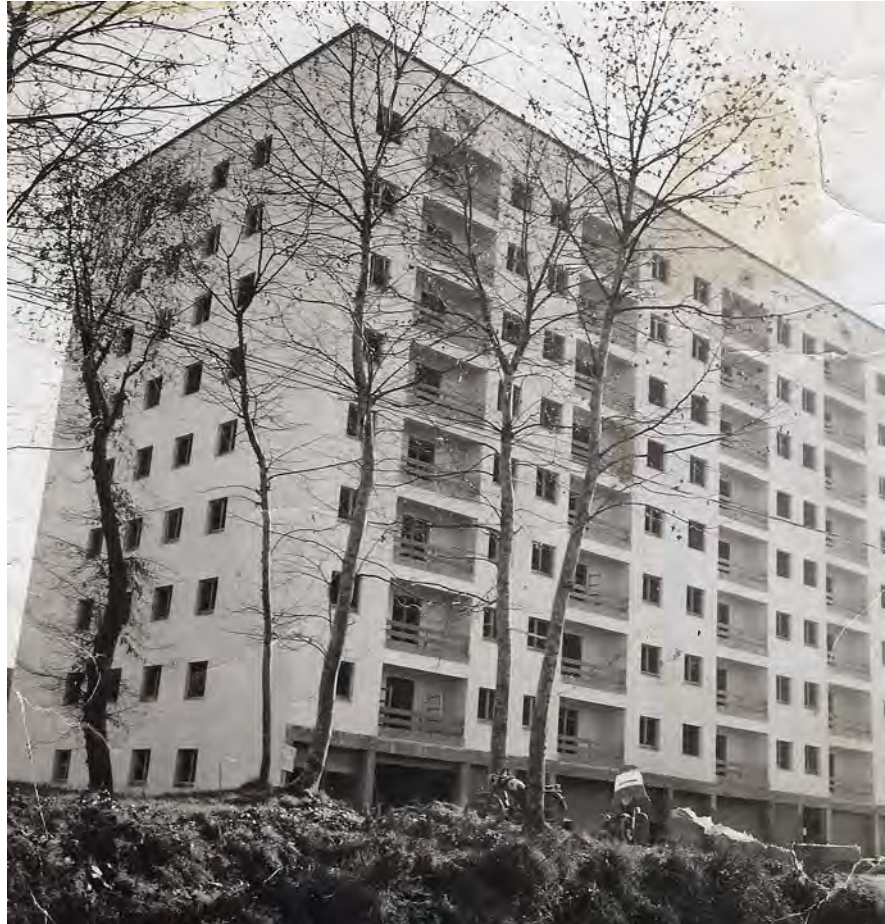
Primer bloque de pisos de la Vecasa, levantado en 1964.
