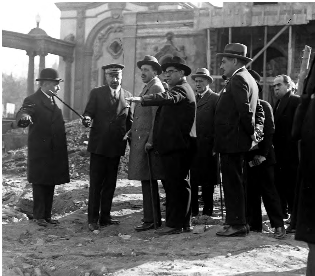
El rey supervisa las obras del Pabellón de Sevilla, en presencia del comisario Cruz Conde y el arquitecto Vicente Traver. Diciembre de 1928.
