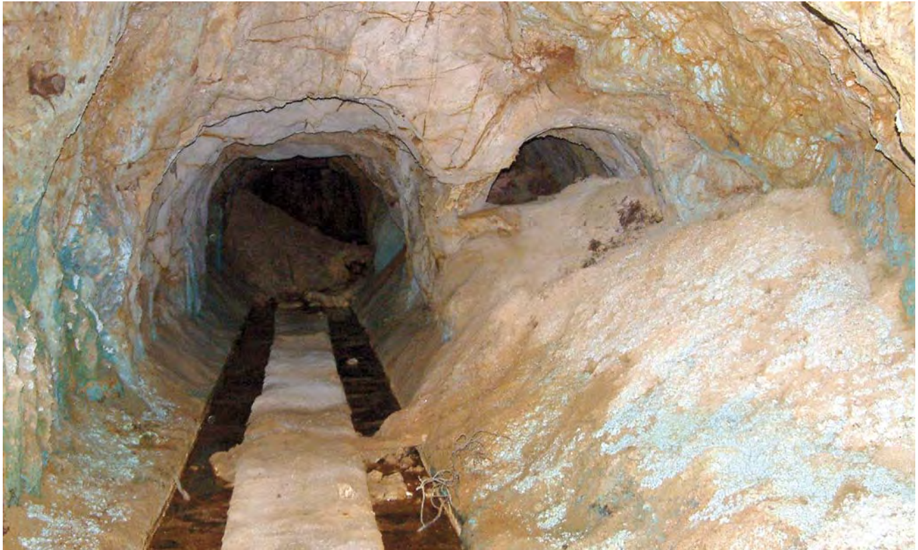
Galería de desagüe de origen romano La Sabina, en la mina de Tharsis.
