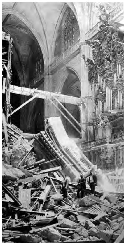
Restos del cimborrio derrumbado en 1888.
