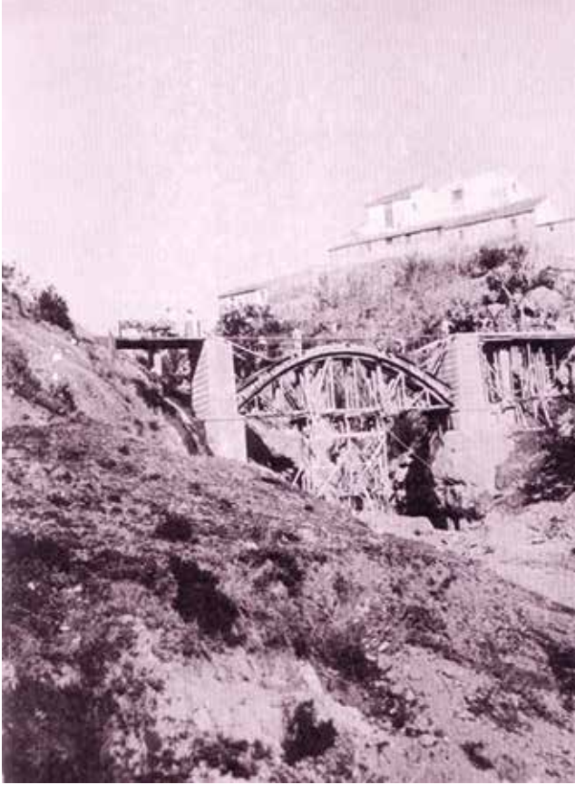
Obras de construcción de un puente del canal construido entre 1923 y 1926 para la nueva traída de las Aguas de Torremolinos.
