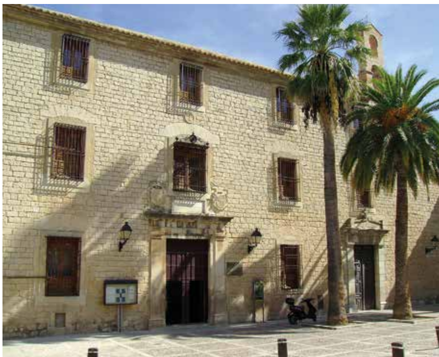
Portada del Palacio de Villardompardo en Jaén.
