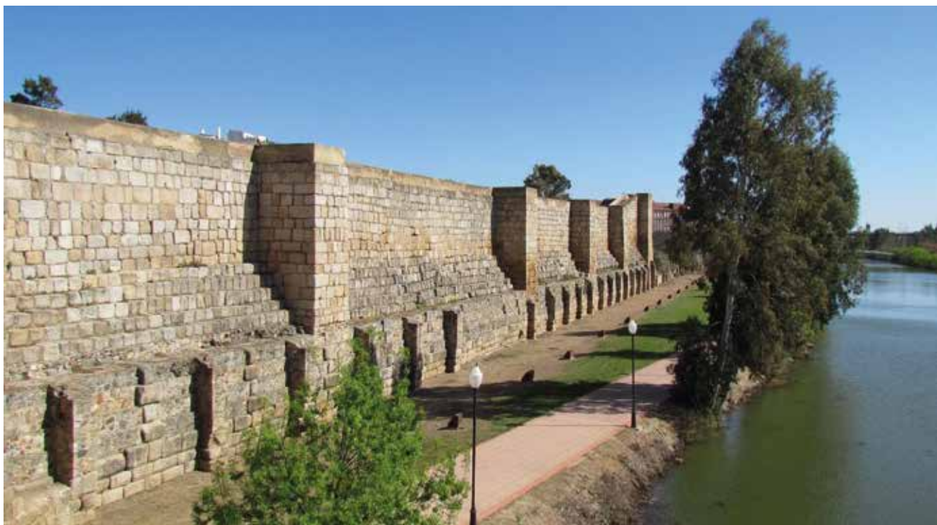
Muralla de la alcazaba de Mérida hacia el río Guadiana.
