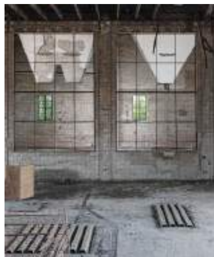
Central Térmica de Hytasa. Estructura monumental de hormigón que articula luz, materia y técnica en el corazón productivo de la antigua central térmica. Autor: Niccolo Guasti.
