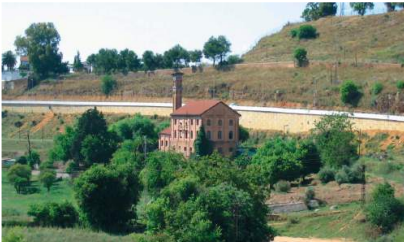
Estación de Bombeo de Adufe (1884, Alcalá de Guadaíra). Central de vapor y bombeo en fábrica de ladrillo visto, hito técnico y arquitectónico de la modernización del abastecimiento de agua potable a Sevilla. Autor: Julián Sobrino.
