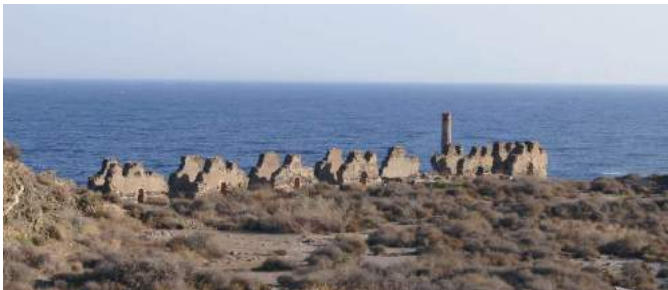
Minería en Sierra Almagrera, Almería. Fuente: Laboratorio del Paisaje Industrial Andaluz.
