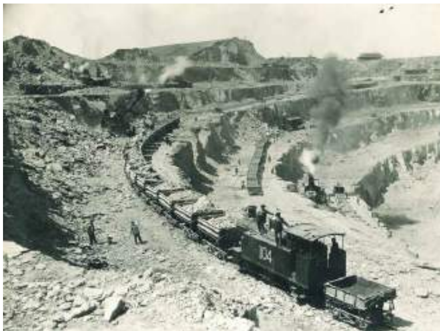
Locomotoras de vapor remolcando vagones de doble vuelco tipo E, conocidos como Moros, cargados mediante excavadoras Bucyrus de 90 toneladas. Corta Atalaya (Minas de Riotinto), 1929. Fototeca del Archivo Histórico Minero Rafael Benjumea, Fundación Río Tinto.
