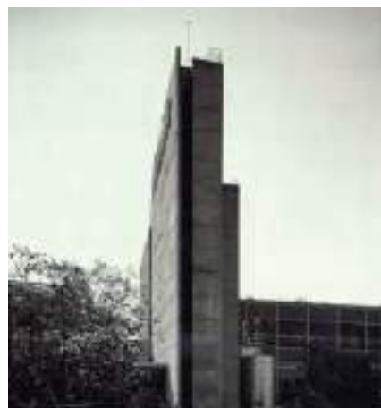
Vista parcial exterior de la fábrica de cervezas de El Águila de Córdoba. Fuente: Docomomo, repositorio de activos digitales del Instituto Andaluz del Patrimonio Histórico.
