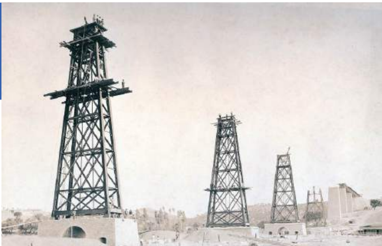
Construcción del Puente del Hacho, en la línea férrea Linares-Almería (1895 ca). Autor: Rafael Garzón, positivo sobre papel aluminado. Fuente: Colección Carlos Sánchez (Granada).
