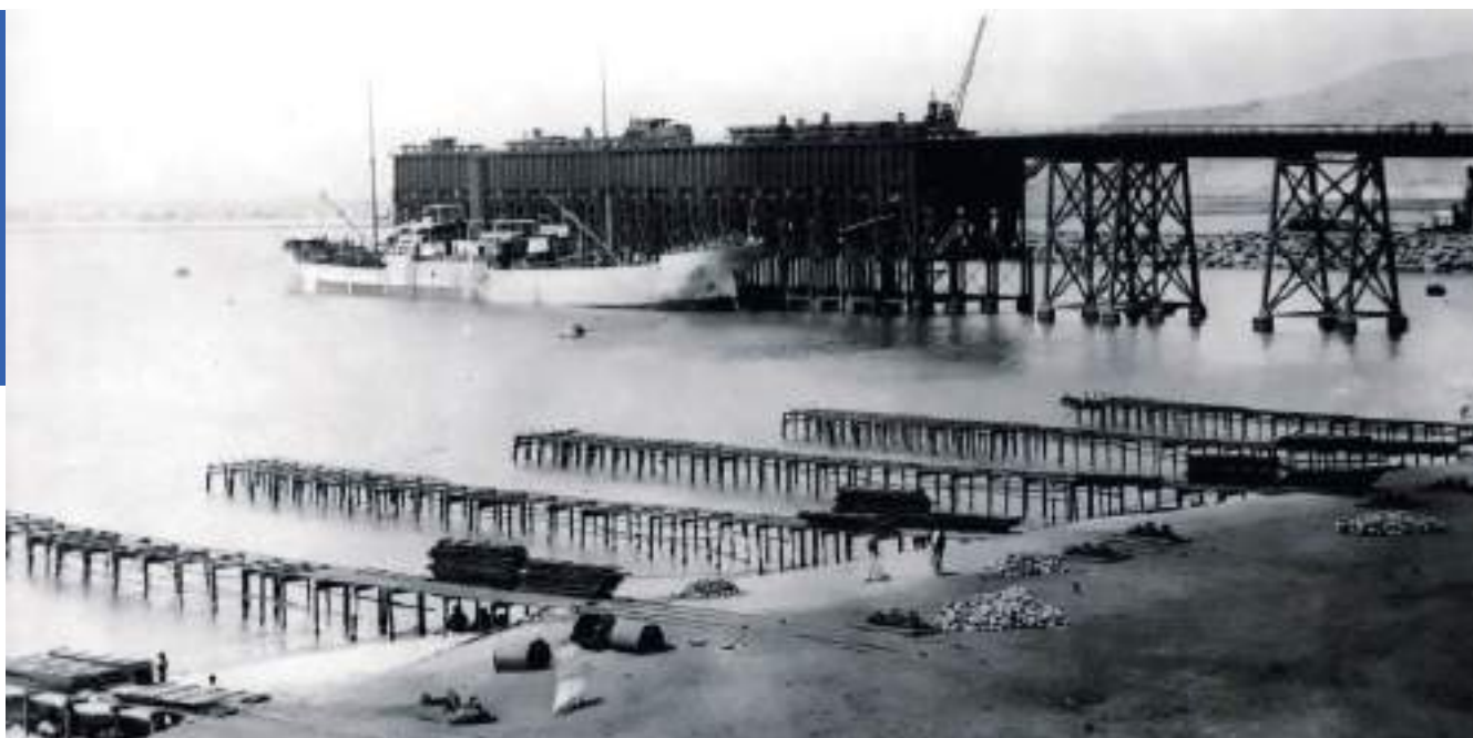
Cable Inglés, Almería. Barcos cargando sus bodegas de mineral. Fuente: Autoridad Portuaria de Almería.
