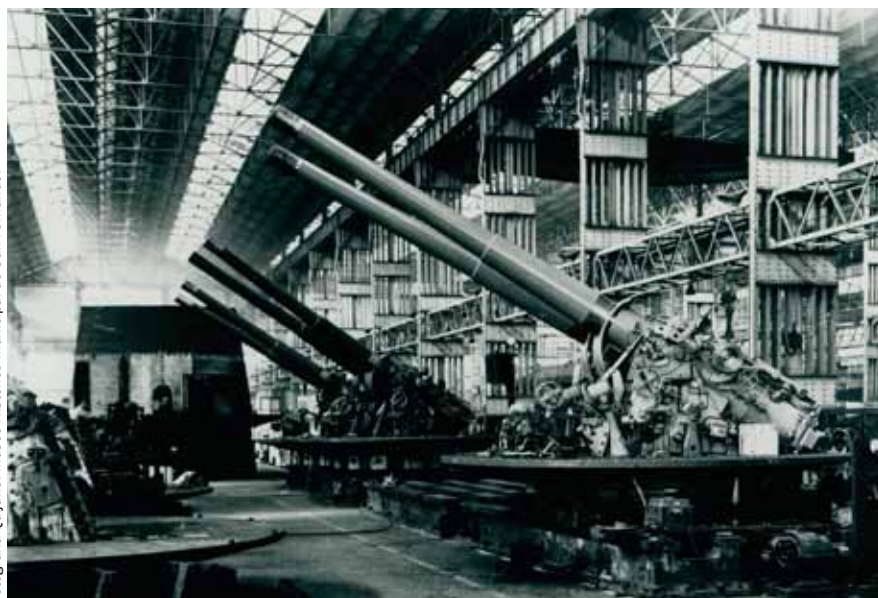
Fábrica de San Carlos, de la S.E. de C.N. Montajes dobles, de 152,4 mm, de patente Vickers y modelo de 1927, para cruceros ligeros de la clase Almirante Cervera .
