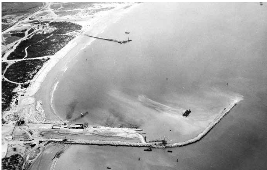
Construcción del puerto de la base de Rota.
