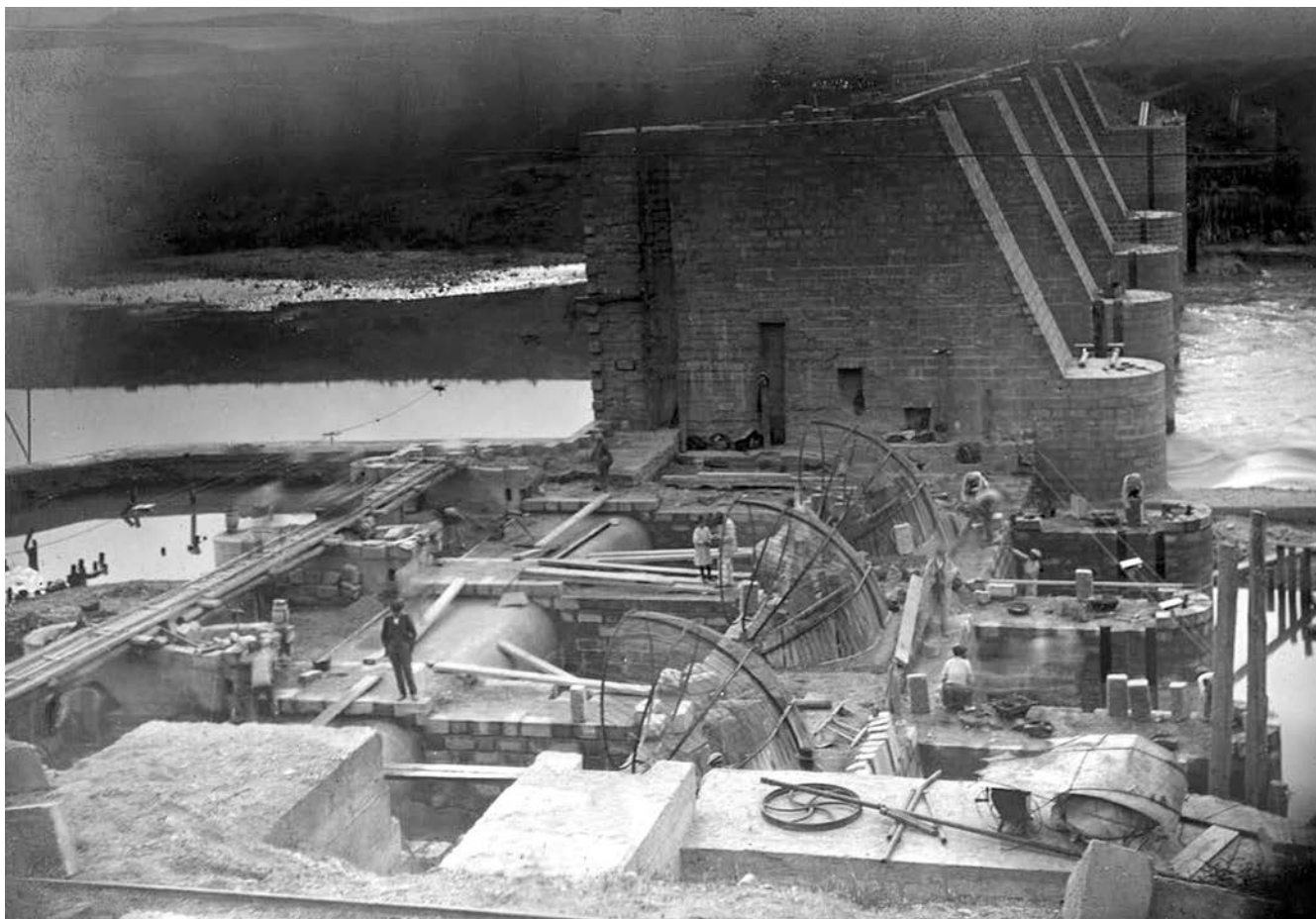
Presa levantada y fase de inicio de la zona de alojamiento de turbinas hidráulicas de la presa de Mengíbar. 1915.
