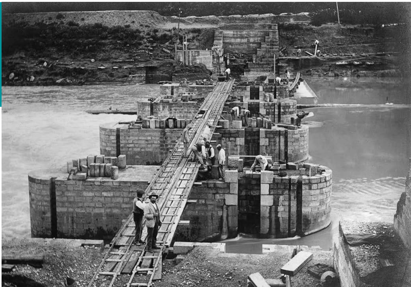
Construcción de las pilas de la presa de Mengíbar. 1915.
